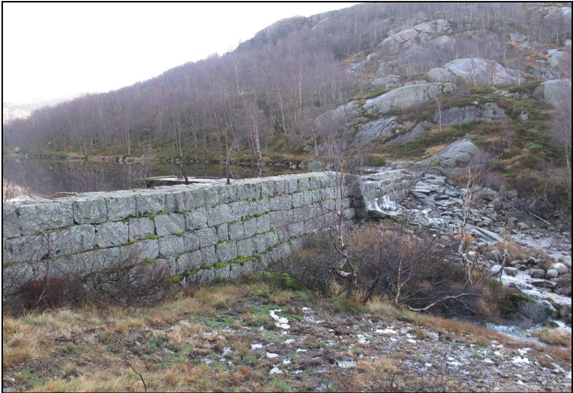
Figur 4. Inntaket er planlagt i forbindelse med eksisterende demning i Kotletjørna. Foto: Bjarne Oddane
